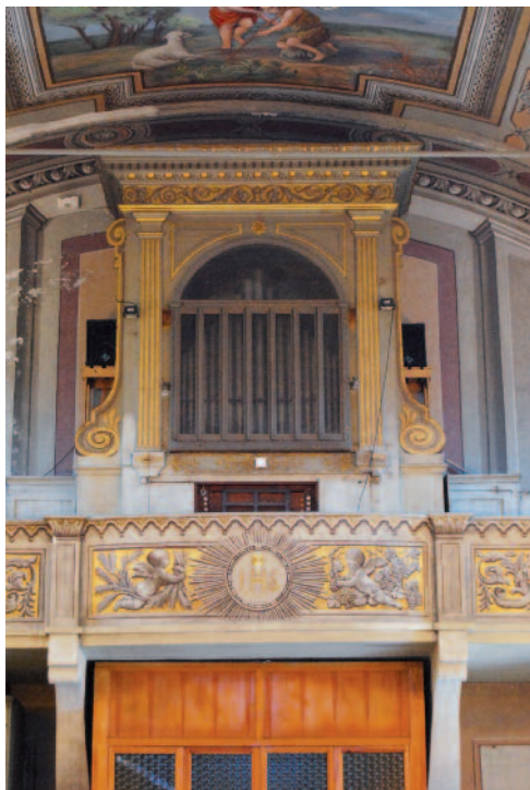
1. Il prospetto è occultato dalla persiana espressiva aggiunta.
