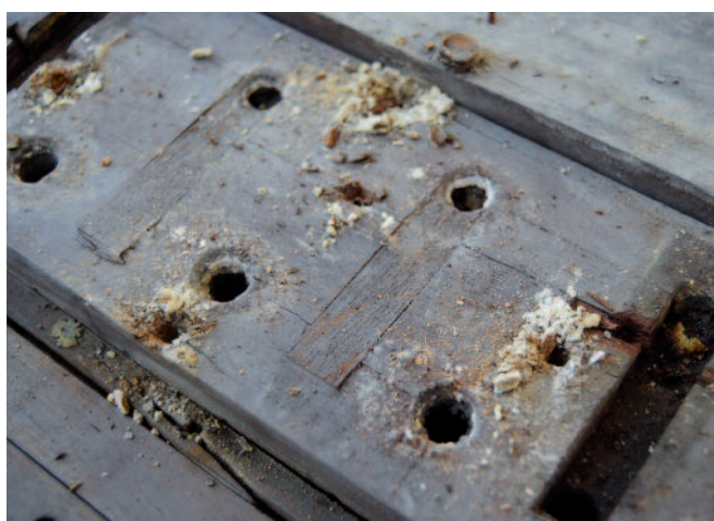
4. Somiere maestro, particolare del livello di degrado dopo l'estrazione dei chiodi.
