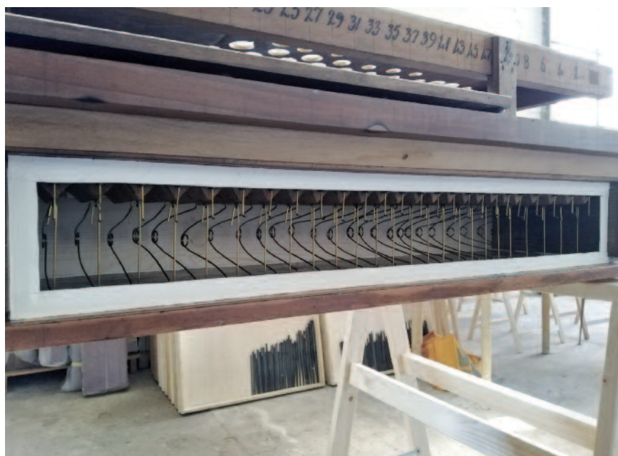
6. Somiere maestro, particolare della secreta ad intervento ultimato.
